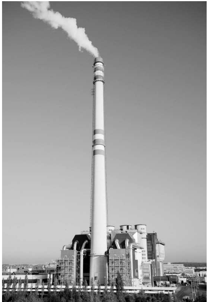
Zařízení na energetické využití odpadu Praha - Malešice
