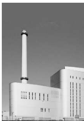
NA TITULNÍ STRANĚ SPALOVNA KOMUNÁLNÍCH ODPADŮ V ROTTERDAMU. FOTO ARCHIV SPOLEČNOSTI CNIM BABCOCK, S. R. O.
