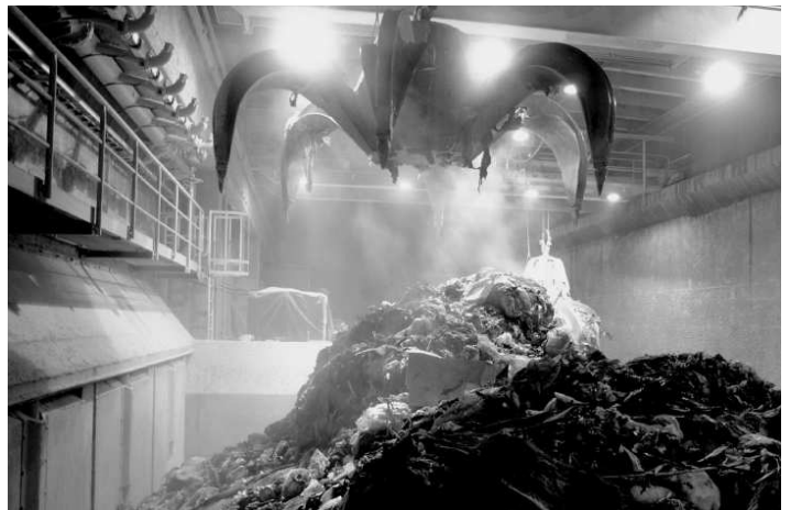
Odpadní silo: Drapák dopravuje odpad na spalovací rošt
