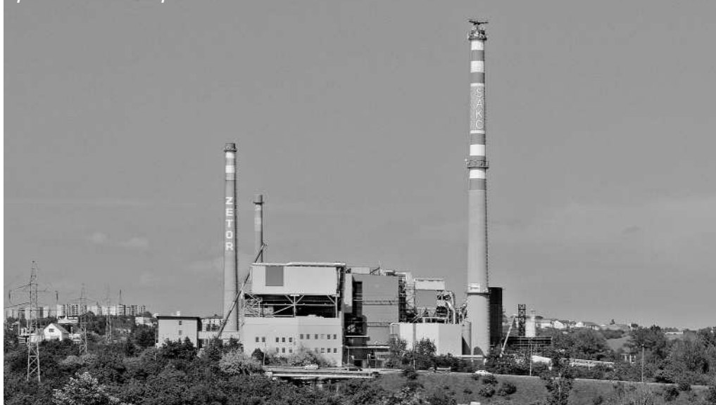
Spalovna SAKO Brno při rekonstrukci. Foto archiv OHB
