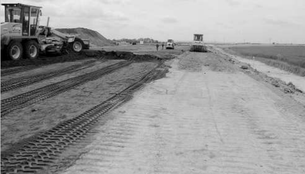
Obrázek 1: Rozhrnování popílku do násypu vymezeného zemními hrázkami (dálnice D11)
