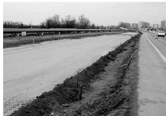
Využití stabilizátu na výstavbu komunikací (obchvat Ostrova nad Ohří)
