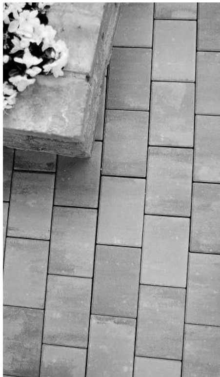
Typické je využití popílků v betonové dlažbě
