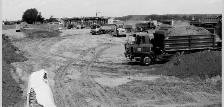
Obrázek 2: Navážení popílku do násypového tělesa (silnice R 35, mimoúrovňová křižovatka Opatovice)
