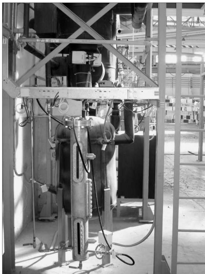
Obrázek 2: Kryokondenzační jednotka
