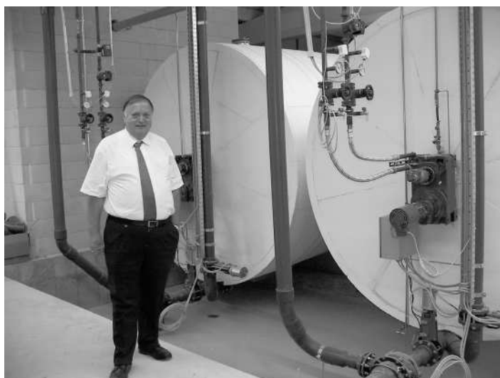
Obrázek 2: Válcové fermentory mají průměr 3 a délku 25 metrů
