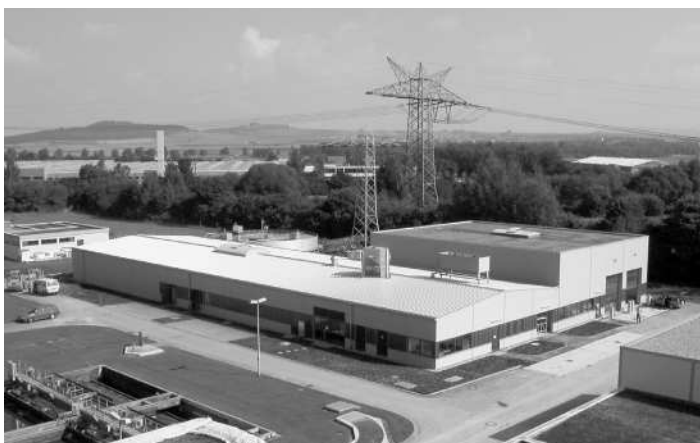
Obrázek 1: Celkový pohled na zařízení v Donaueschingen (SRN)
