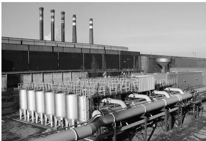
Nová filtrační stanice chladicí vody s využitím kontinuálních pískových filtrů, průtok 6 200 m 3 /h
