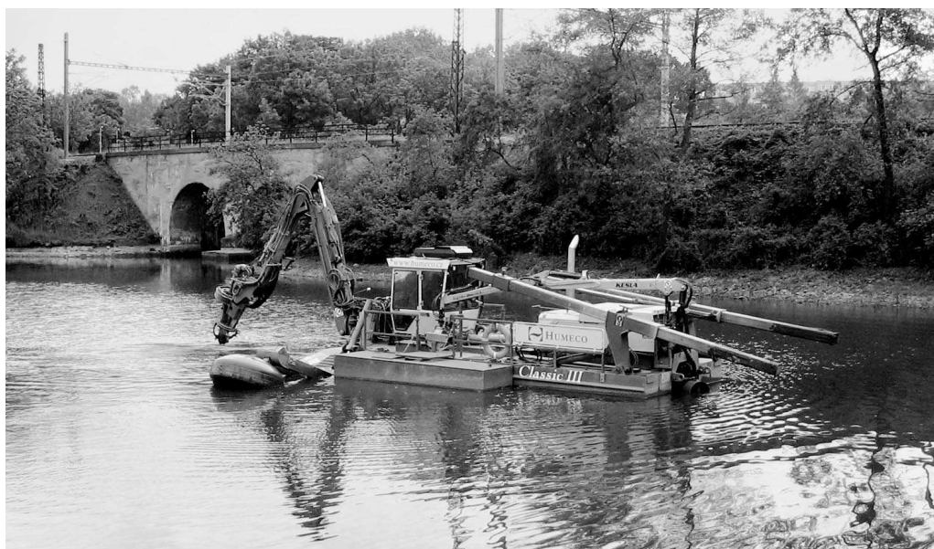
Obrazek: Sací bagr při revitalizaci Kyjského rybníka na Rokytce v Praze
