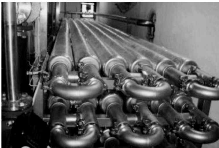
Pasterizační zařízení bioplynové stanice na kuchyňské odpady
