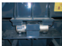
Instalace tenzometrického snímače mezi šasi a nástavbou svozového vozu
