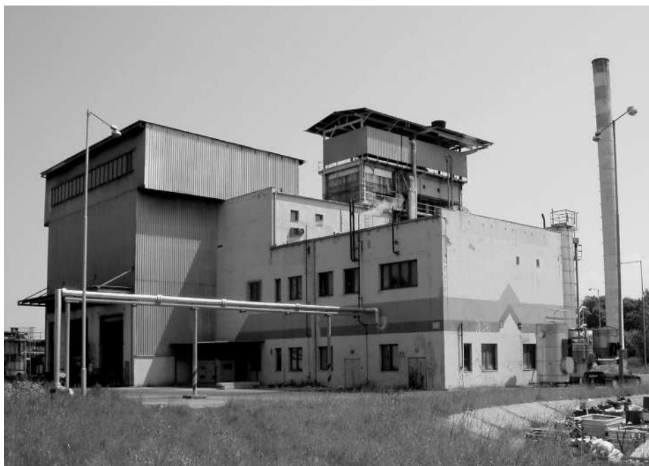
Pohled na dnešní spalovnu v Rybitví
