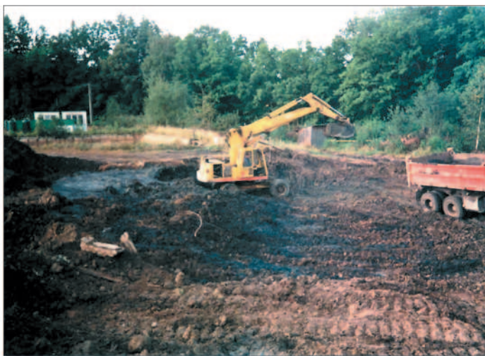
Obrázek 2: Těžba kontaminovaných zemín v areálu JDZ Soběslav, a. s.
