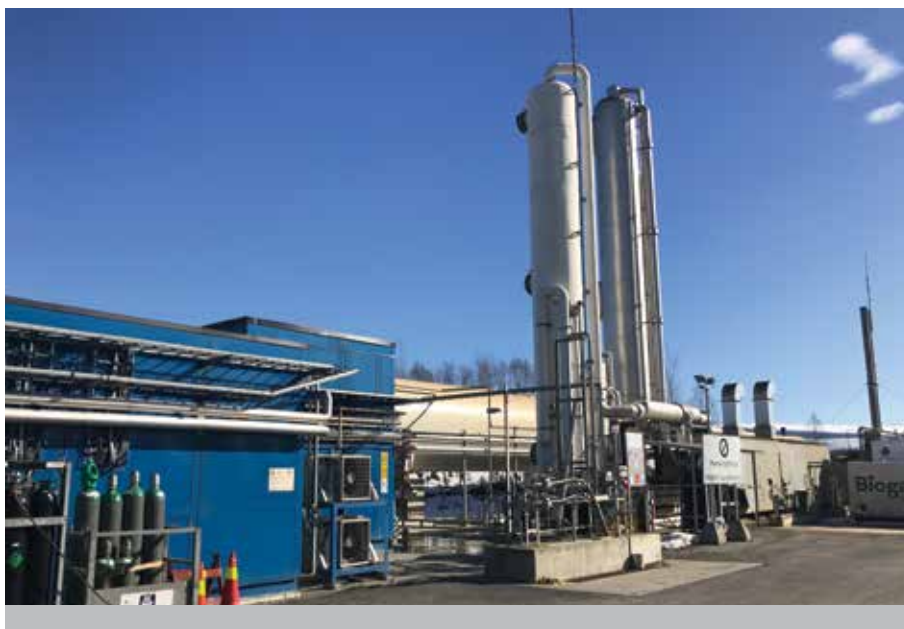
Obrázek 3: Vytěžený bioplyn je dočištěn, zkapalněn a převážen zpět do města kde na něj jezdí místní autobusy MHD. Celý rok jich tak na bioCNG jezdí 135
