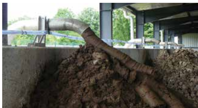
Příklady možného užití technologie: Úložiště kalů (250 m 2 ) – použito difuzní zařízení s gelovými pláty, zakončené perforovanými hadicemi okolo úložiště pro distribuci látek
