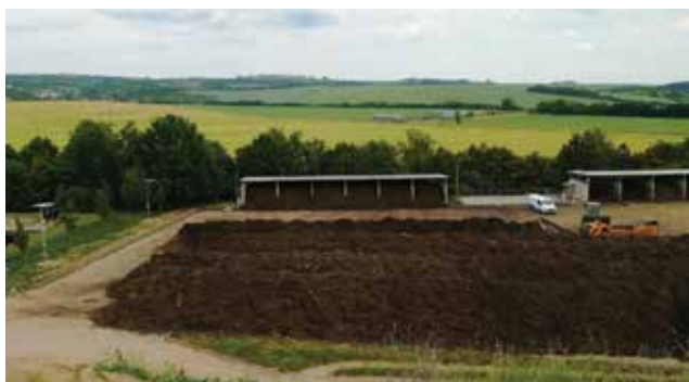
Kompostárna (5 400 m 2 ) – použito difuzní zařízení s gelovými pláty, zakončené vysokootáčkovými ventilátory pro distribuci látek
