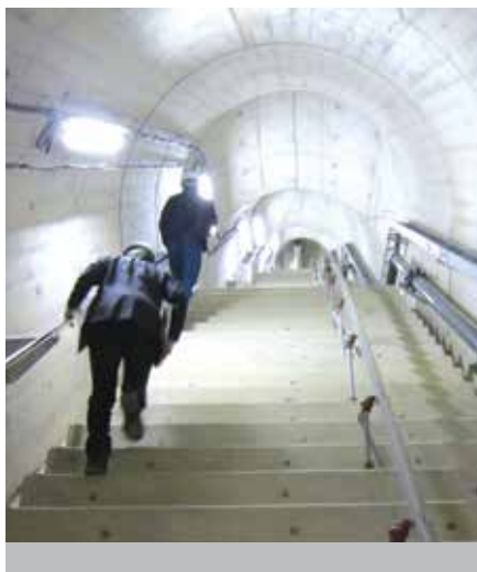
Obrázek 2: Skládka Wakkaniai – Podzemní systém skládky pro sběr výluhů. Obdobné šachty mají i některé skládky v Evropě.
