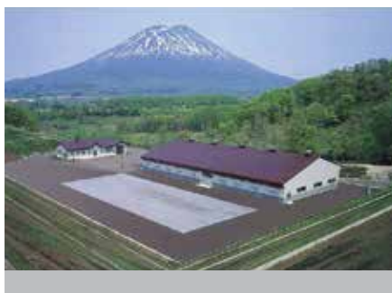
Obrázek 1: Skládka Niseko, Hokkaido, rok výstavby 2002, plocha 1000 m 2 , hloubka 4,5 m, nespalitelný odpad, bez vrchní izolace, výluh se odvádí do řeky.
