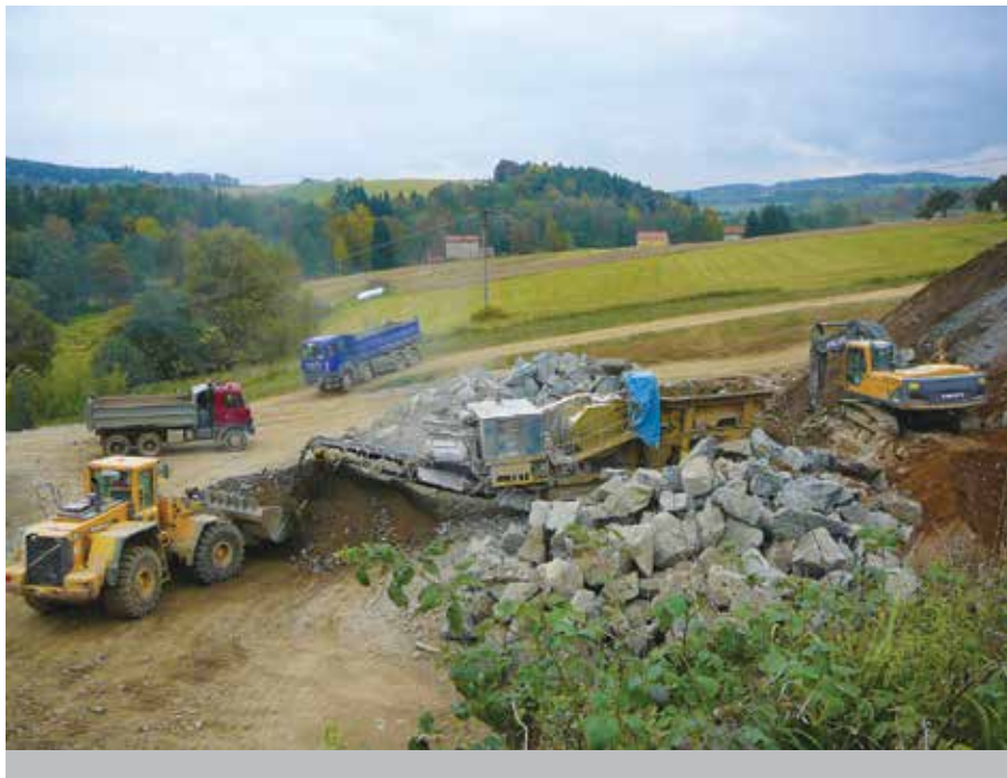
Budování železničního náspu z drceného kameniva v Heřmaničkách
