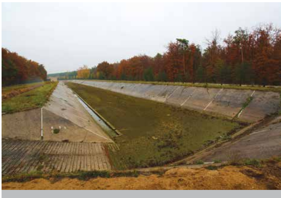
Vsakovací nádrže umělé infiltrace v ÚV Káraný
