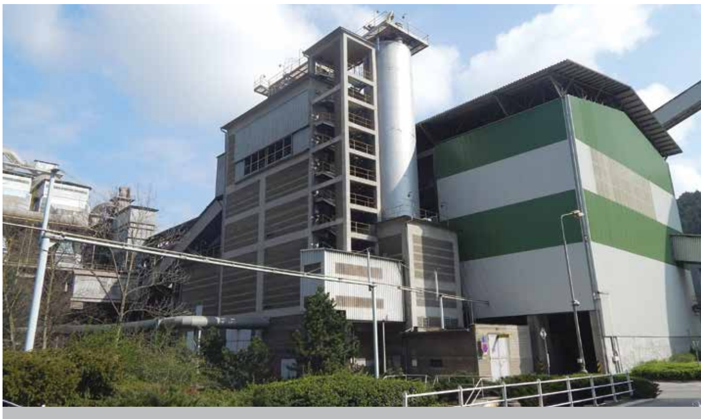
Českomoravský cement, a.s., je největším výrobcem cementu v České republice. Výroba probíhá ve dvou závodech: v Praze Radotíně a v Mokré nedaleko Brna.
