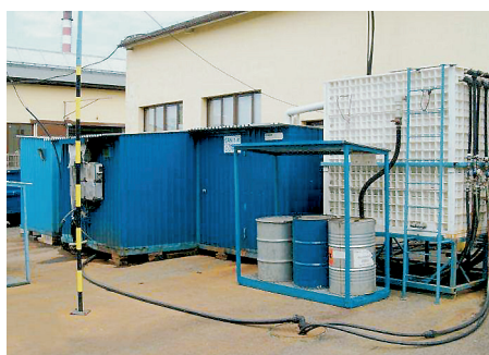
Obrázek 3: Sanační stanice pro aplikaci manganistanu draselného
