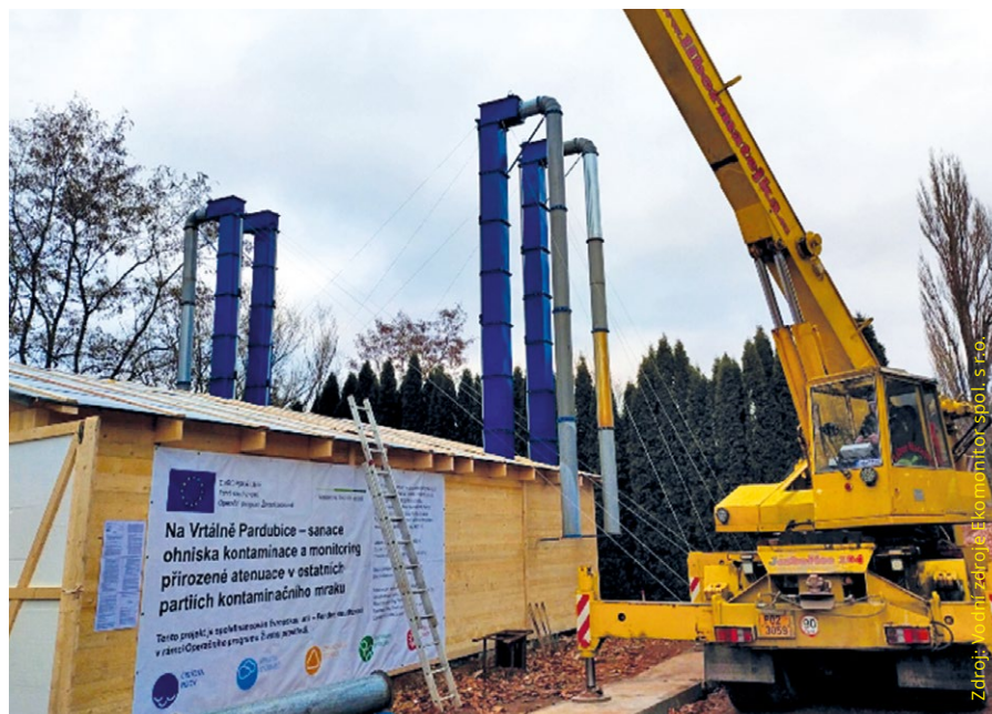
Výstavba dekontaminační stanice
