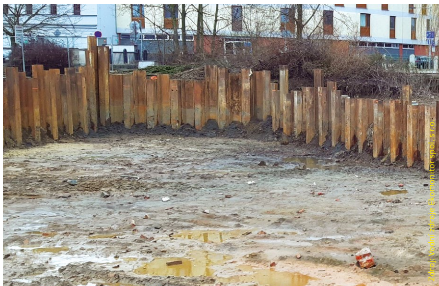
Štěťová stěna před realizací kotev
