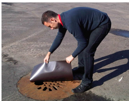
Magnetická kanalizační ucpávka - instalace
