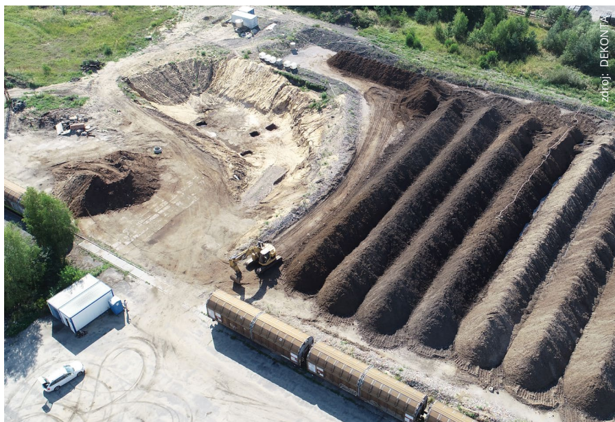
Obrázek: Celkový pohled na ko-kompostování zemin a sanační výkop
