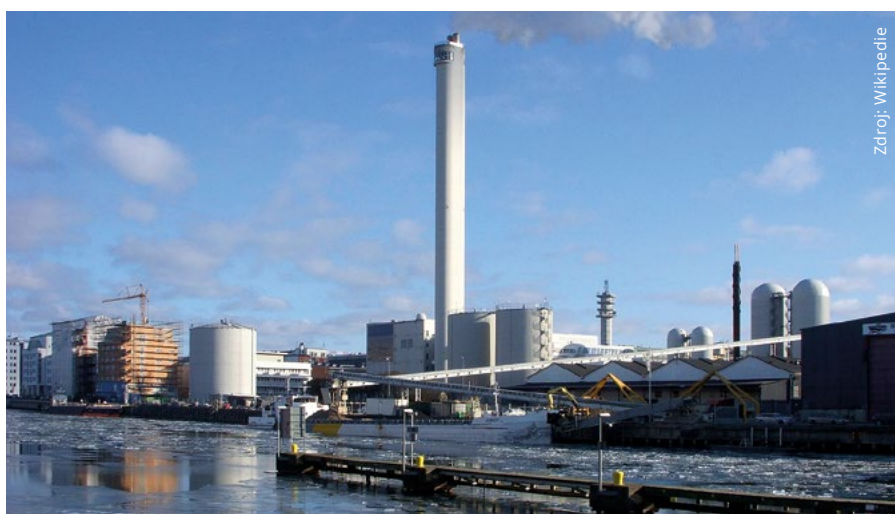
Pohled na Stockholmskou teplárnu Hammarbyverket. Kromě záložního zdroje na topný olej je zde instalováno celkem sedm tepelných čerpadel o celkovém výkonu 225 MW, která využívají energii obsaženou ve vyčištěné odpadní vodě z nedaleké ČOV.
