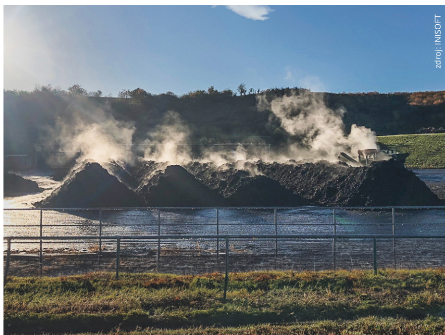
Kompostárna Hantály ve Velkých Pavlovicích
