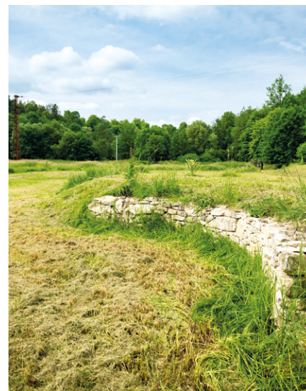
Přírodě blízká protipovodňová ochrana v Dolním Újezdě
