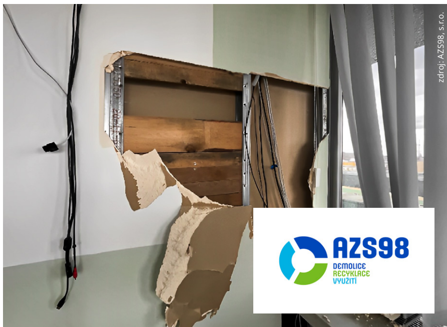
Ukázka provádění sond ve stavební konstrukci
