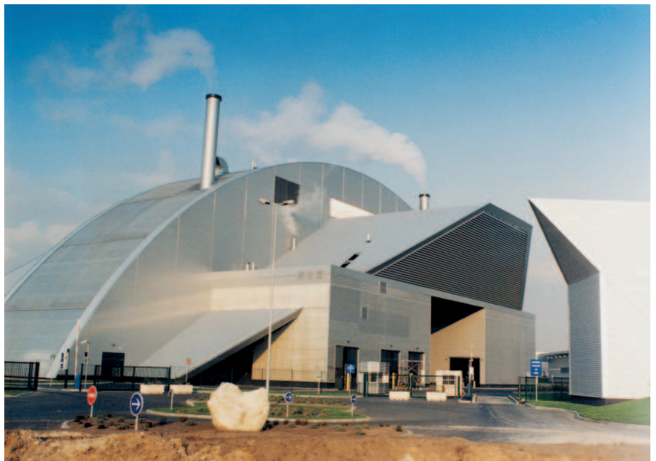
Zařízení Waste-toEnergy v Cergy, Francie
