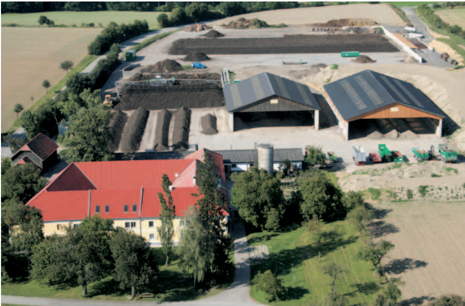
Obrázek.: Kompostárna s řízeným provozem H. Seiringer
