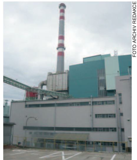
Spaľovna SAKO Brno po rekonstrukcii
