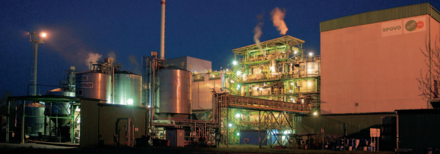
Obrázek 1: Spalovna průmyslových odpadů v Ostravě
