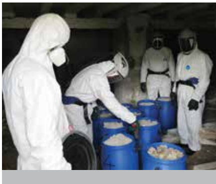
Přebalování nebezpečných odpadů uvnitř skladu na lokalitě Monte Café
