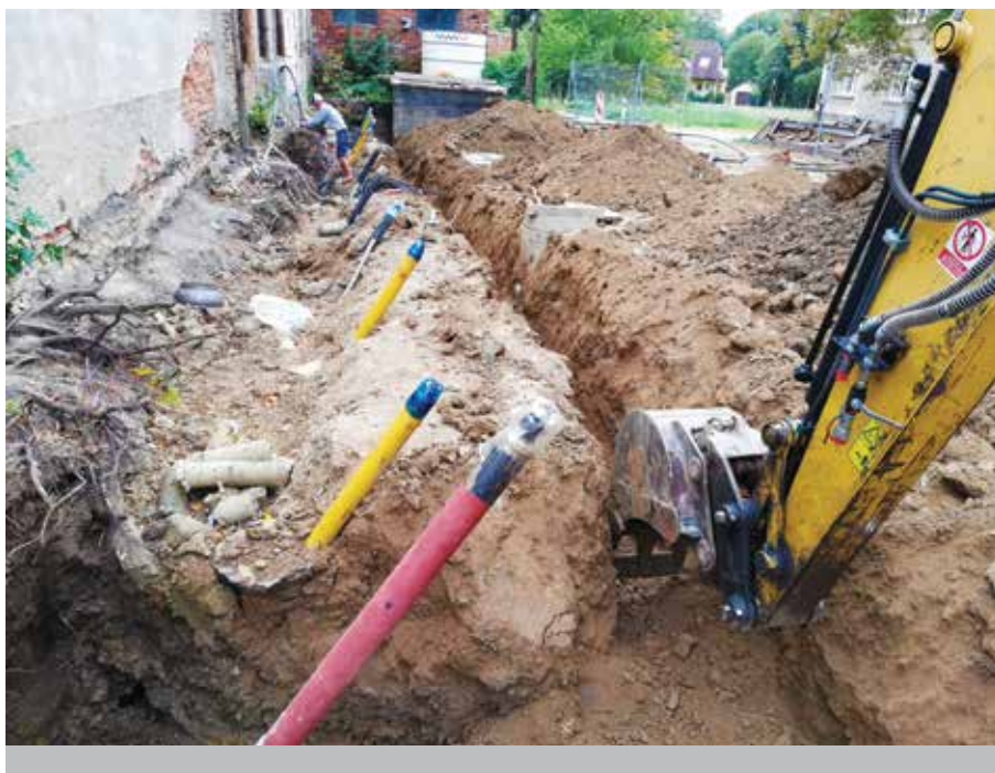
Ventingové vrty a výkop pro potrubí a kabeláž
