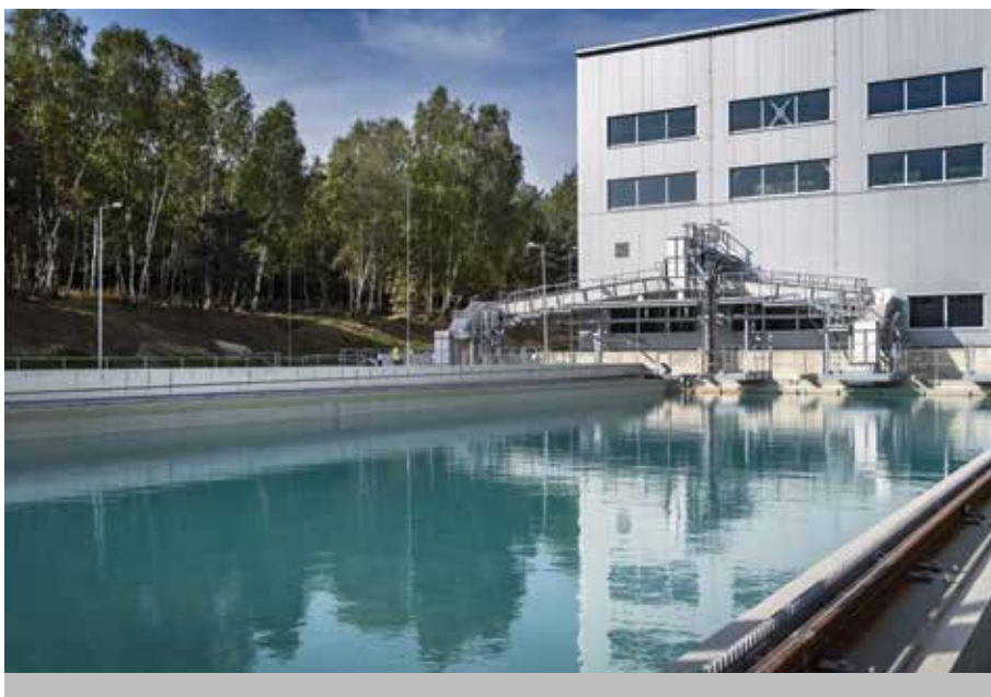
Nátok suspenze sraženiny do sedimentační nádrže
