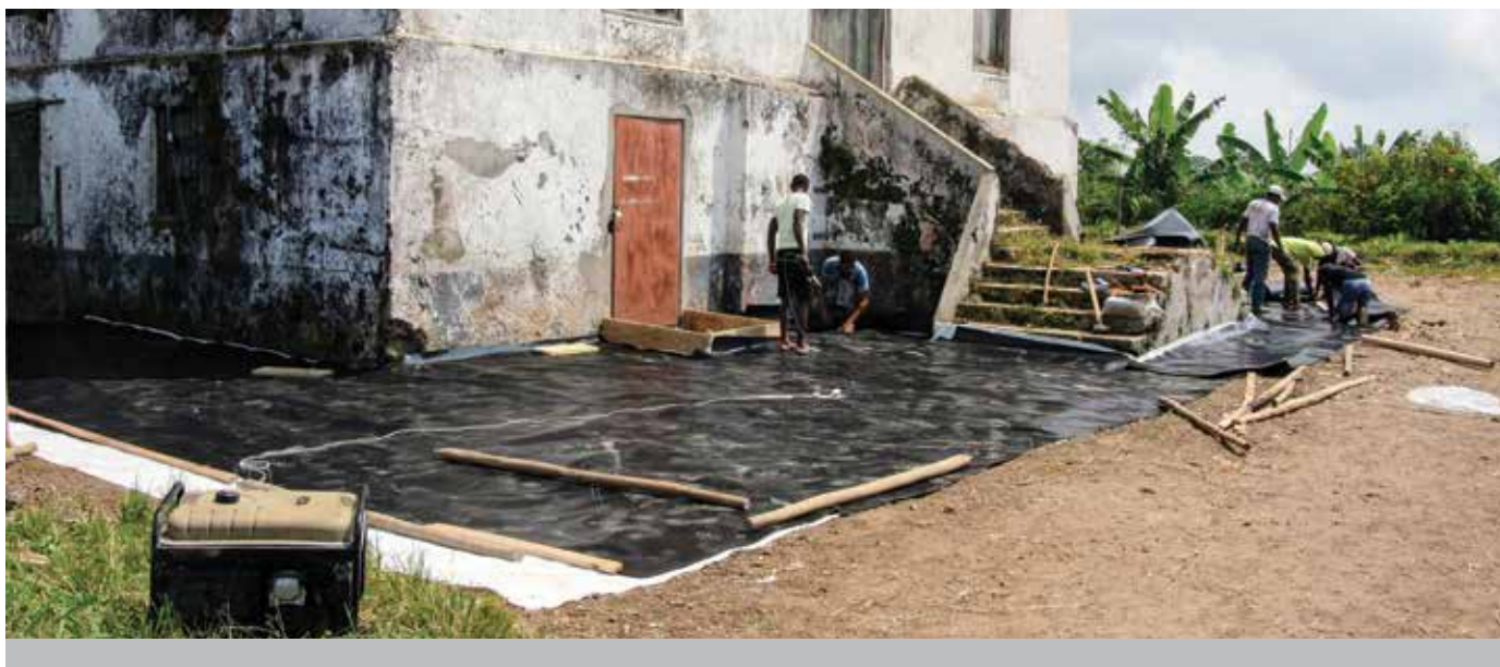
Práce na eliminaci rizik z reziduálního znečištění zeminy v okolí skladu na lokalitě Monte Café
