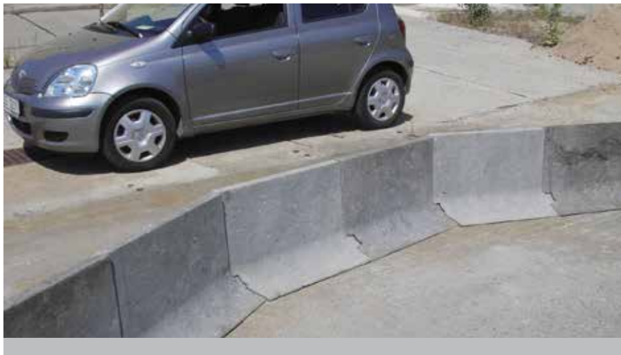
Plastové mobilní svodidlo z recyklovaného směšného odpadu.
