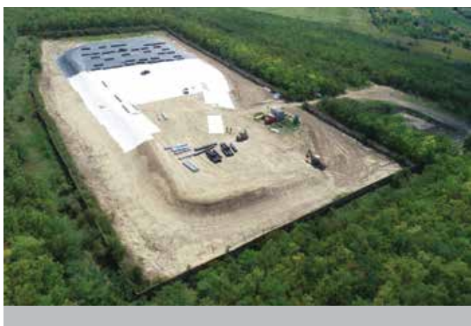
Pokládka izolačních vrstev – červenec 2019.
