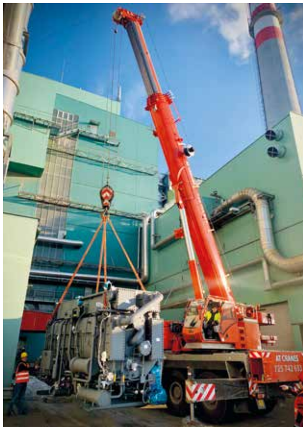
Transport absorpčního tepelného čerpadla
