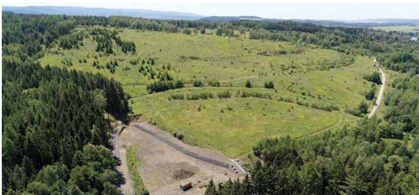
Obrázek 1: Výsypka lomu Hájek (v popředí vyčištěná plocha pro vybudování systému Wetland+).
