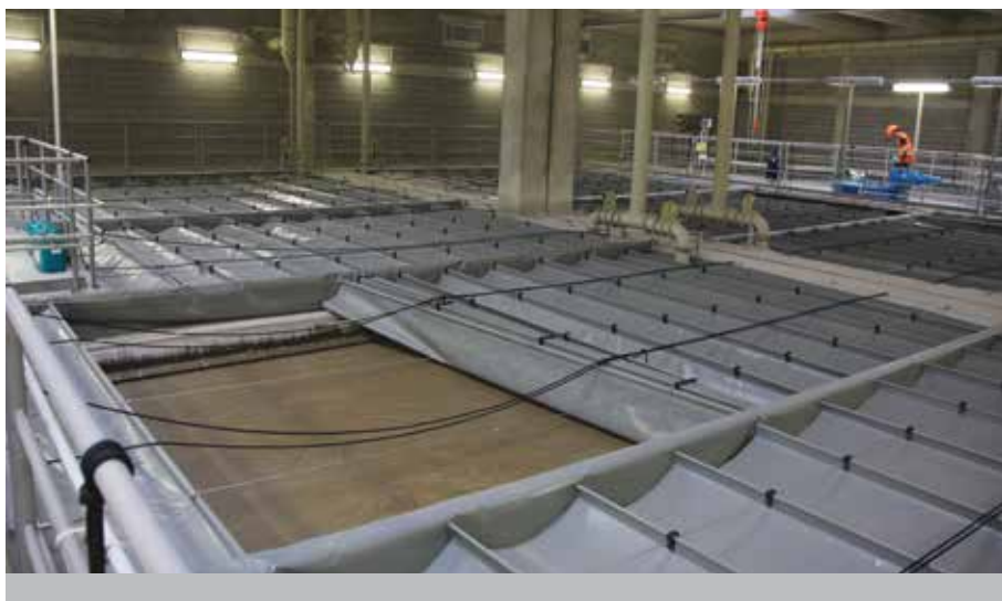
Foto 6: Zakryté nádrže Densadeg v Hrubém a mechanickém začištění.
