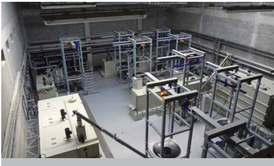
Foto 2: Nádrže na polymery v Hrubém a mechanickém předčištění.
