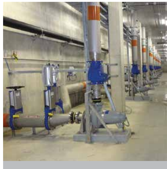
Foto 3: Čerpadla v kolektoru pro vratný kal.
