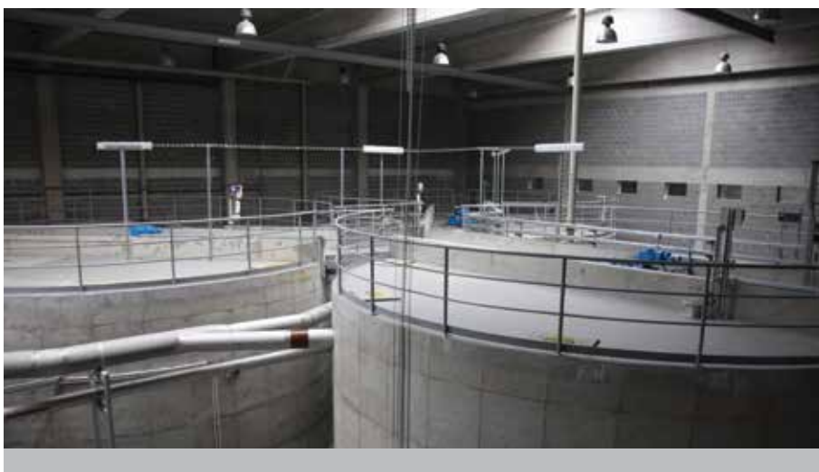
Foto 5: Nádrže pro zahuštění vratného kalu.
