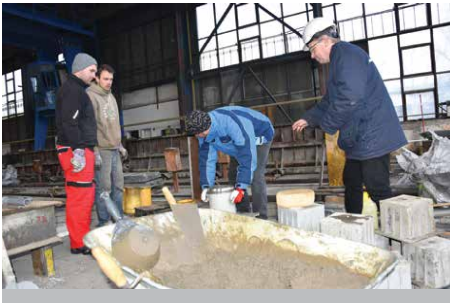
Lití těžkého betonu.
