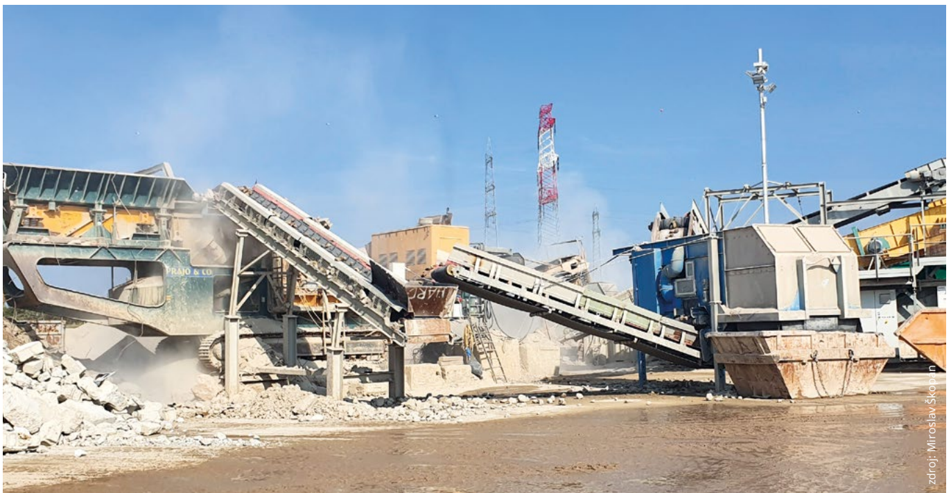
V Německu, Rakousku, zemích Beneluxu a ve Švýcarsku se v porovnání s ČR užívají značně komplikovanější strojní celky, které zajistí zejména potřebnou stabilitu vysoké jakosti produktů. Na obrázku je recyklační linka pro betonovou suť RCH Recycling Center Himberg GmbH, Wien
