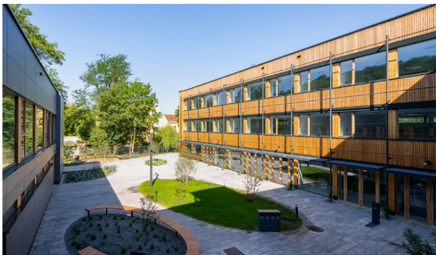
Revitalizace školy Českobrodská v Praze 9
