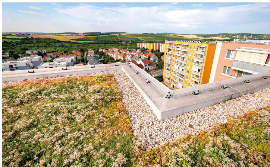
Zelená střecha na panelovém domě v Brně
